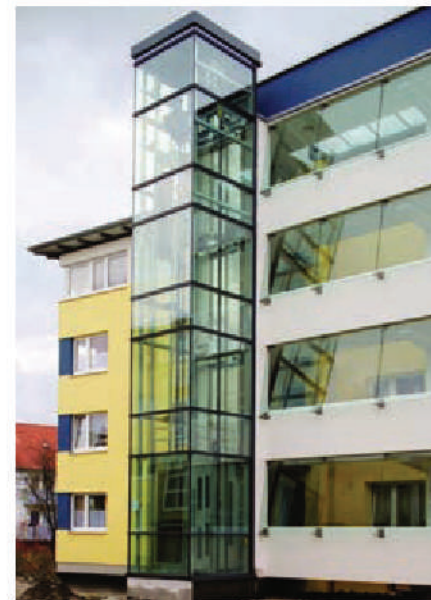
Thang máy gia đình lắp đặt ngoài trời
